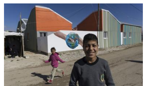
L'école a été construite à partir des éléments du pavillon Save the Children Italia de l'Expo universelle de Milan. © CATALYTIC ACTION
